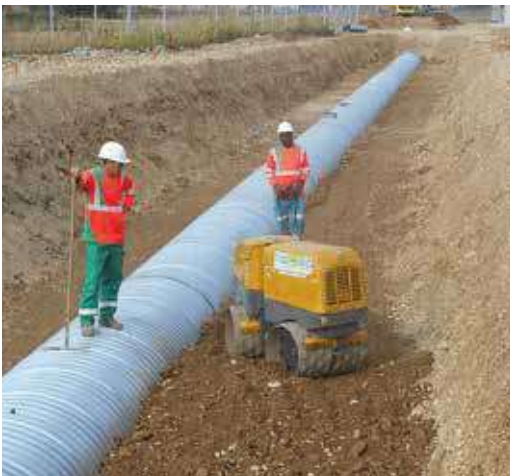
Lit de pose propre et stable
