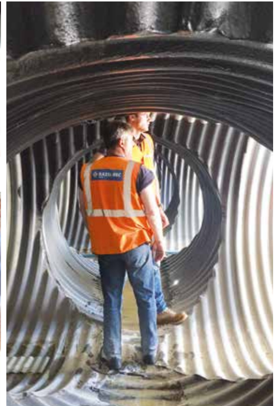
Visite d'un réservoir multilignes avec galerie transversale de communication hydraulique et technique
