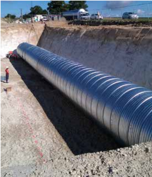
Lit de pose propre et stable
