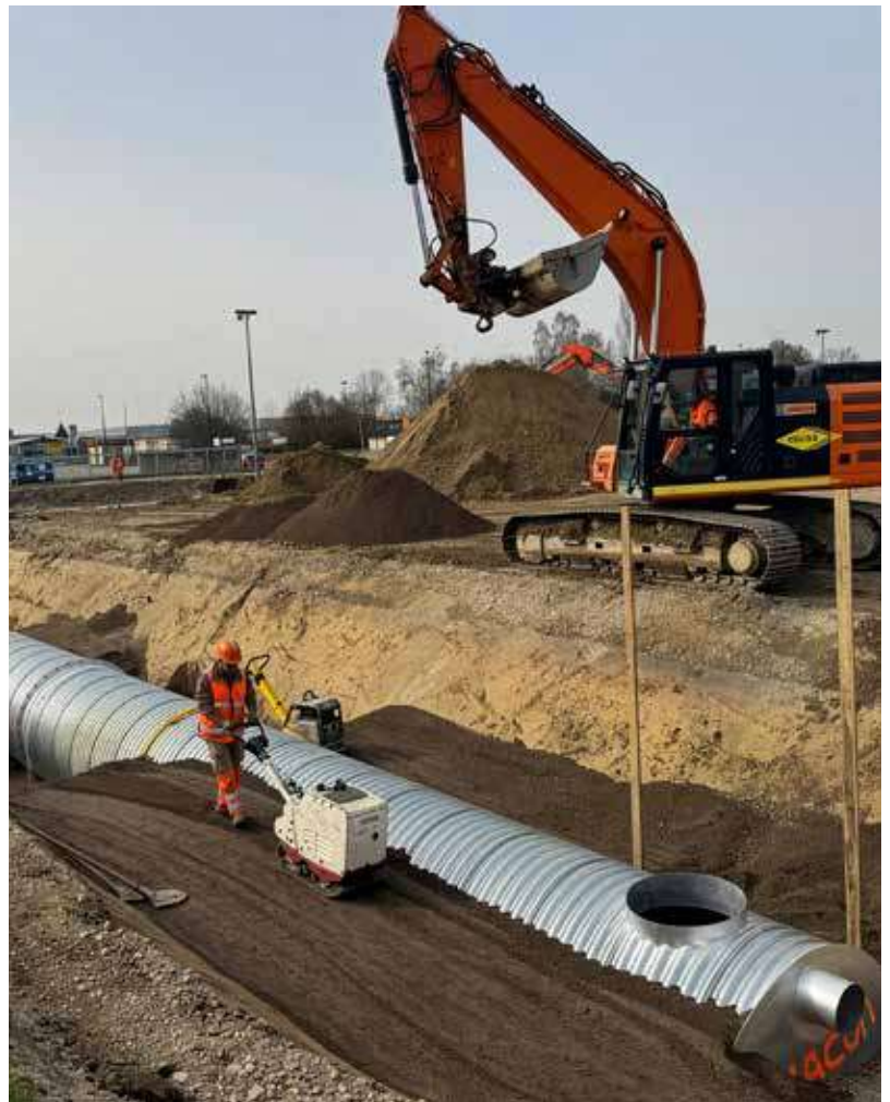
Compactage par couches symétriques de 30 cm
