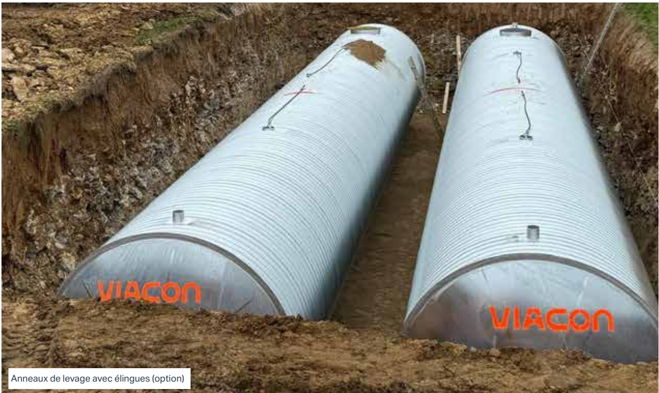
Cuves jumelées par pièces à brides
