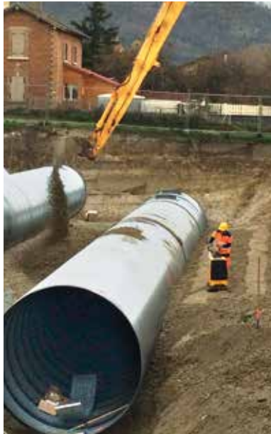
Compactage par couches symétriques de 30 cm
